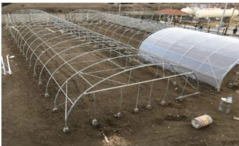
شکل ۴۰. گلخانه کوچک مقیاس در حال احداث
