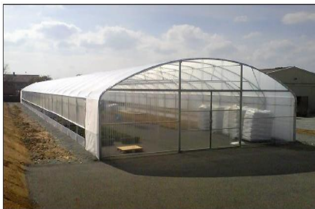
شکل ۱۳. تیپ عمومی گلخانه تونلی ایستاده تک دهانه (Straight)
